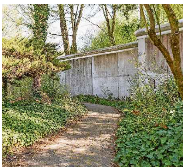
Der Tiefgarten ist durch eine Mauer gesichert.
