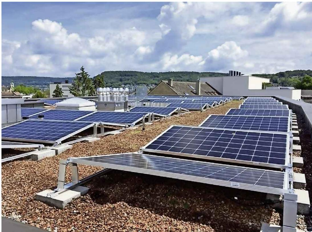
Dach der «Residenz zur Linde»: Auf den 150 Quadratmetern sind 92 Photovoltaik-Panels verlegt worden.
