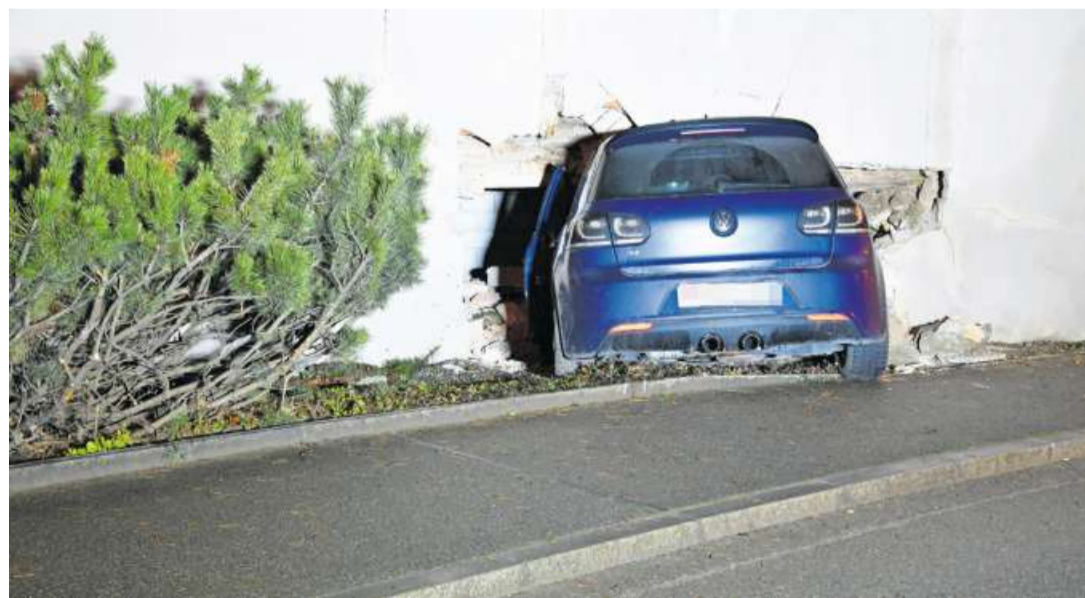
Der blaue VW Golf verpasste die Rechtskurve und durchbrach die Hausmauer.
