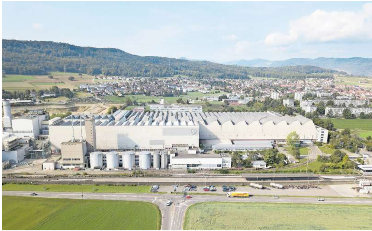
Die Industriehalle in Brugg gehörte BBC, ABB, Alstom und schliesslich General Electric.
