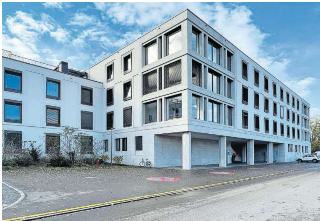
1041 Solarpanels sollen auf dem Dach des Hauptgebäudes Magnolia installiert werden.
