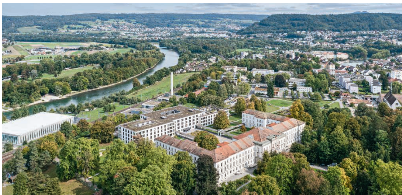
Sicht auf die Westseite des PDAG-Geländes, wo die Schächte für die Grundwasserpumpen gebaut werden sollen
